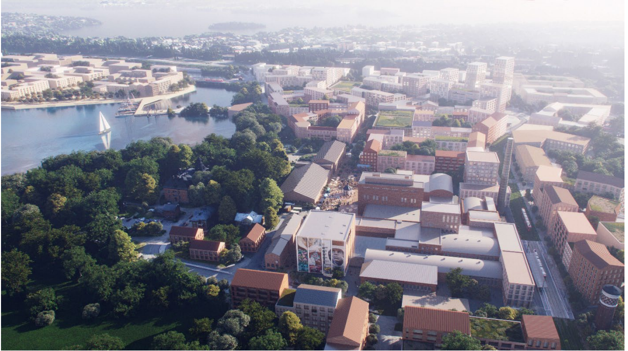
Kuva 1. Kansikuva, ilmahavainnekuva Hiedanrannan Tehtaasta (ARCO Architecture Company 2025)
